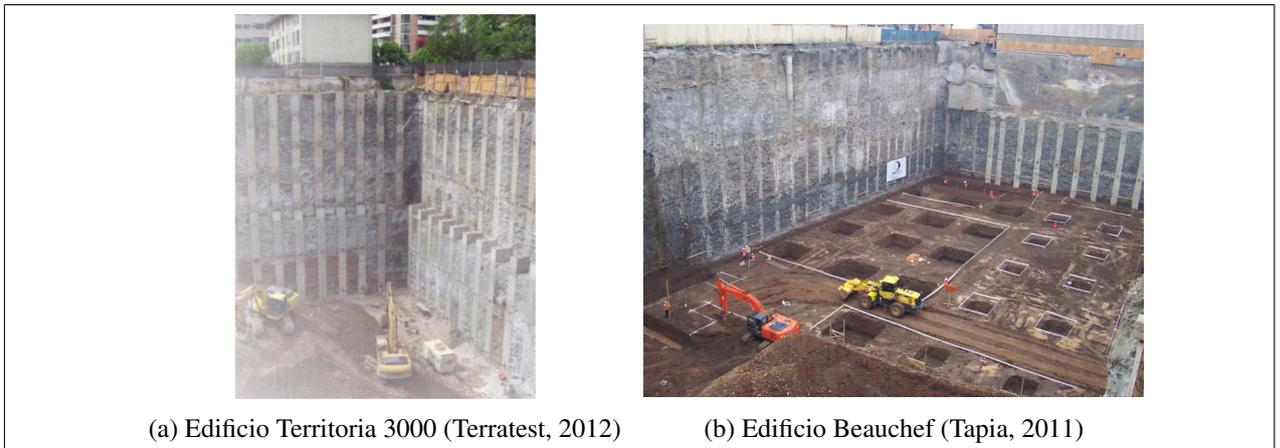
Figura 1.1: Excavación con pilas de socalzado
