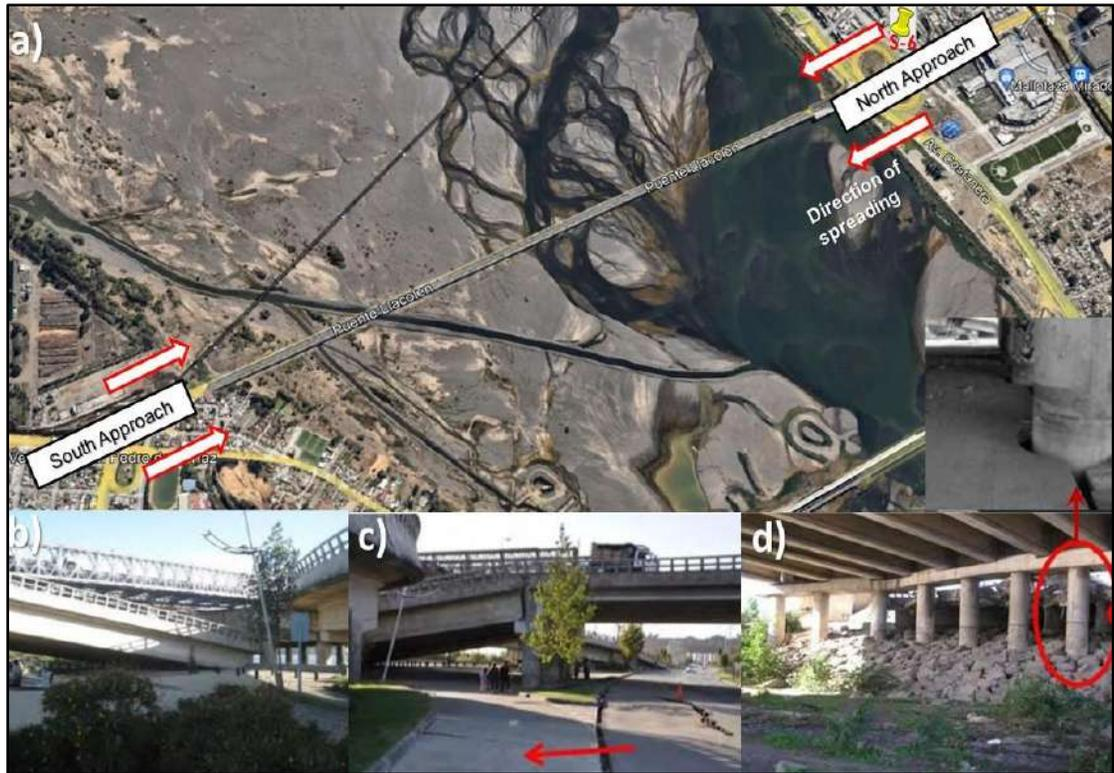
**Figura 5. 11** Desplazamiento lateral en el puente Llacolén (a) Google Earth® del puente Llacolén y dirección del desplazamiento lateral en el tablero norte y sur (b) Vista al sur del tablero desalojado (c) Vista al norte del tablero desalojado (d) Subestructura del acceso norte (Bray y Frost [64])
