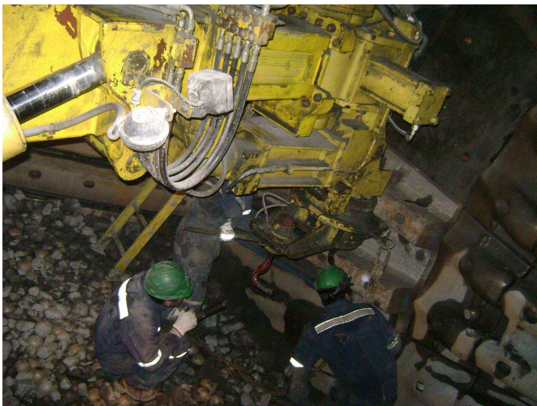
FIGURA B.1. Montaje de un revestimiento en la pared interior del molino SAG
