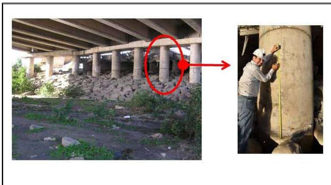
Figura 3-9: Grietas de flexión en las columnas de soporte del tablero que se cayó en el terremoto (Eje 45 del puente).
