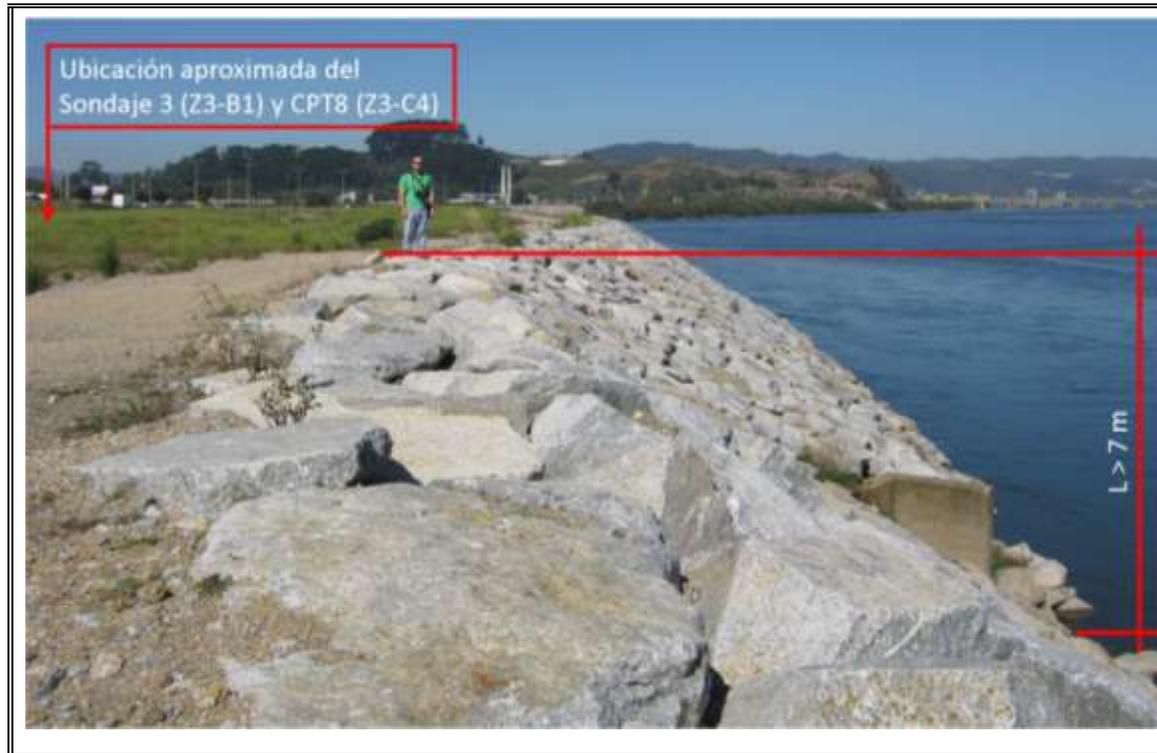
Figura B.3.1- 1: Vista de la diferencia de cotas, entre las exploraciones realizadas por IDIEM (2012) e INGEXA (2010)
