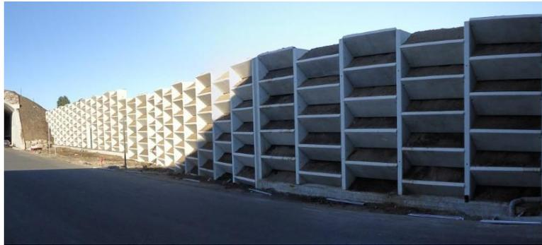
Fig. 22. Pantallas acústicas Fuente: Evaluación de la pérdida de inserción de una barrera acústica aplicada en un proyecto lineal, Esteban Olmos, 2002.
