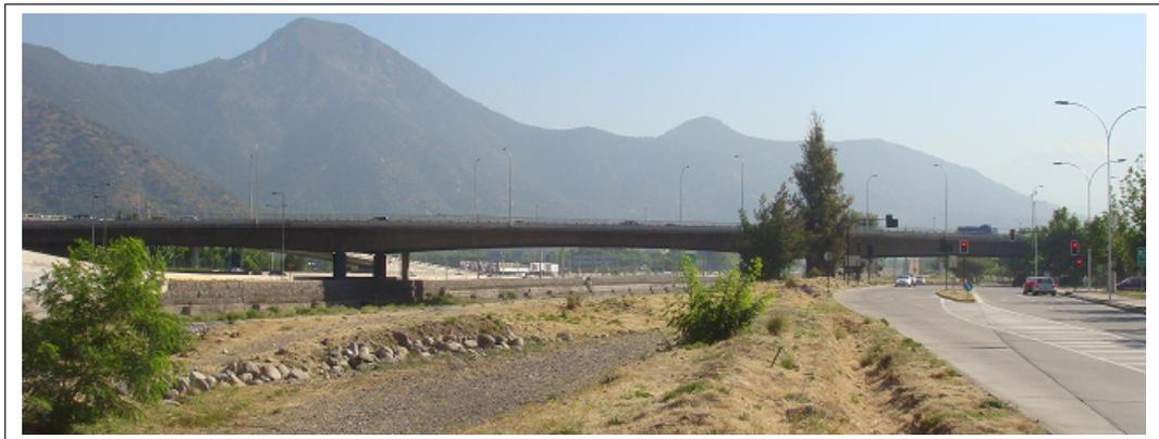
FIGURA 2.2. Vista lateral del puente Centenario. Se observan las tres luces del puente, y la variación de la sección transversal de las vigas cajón.
