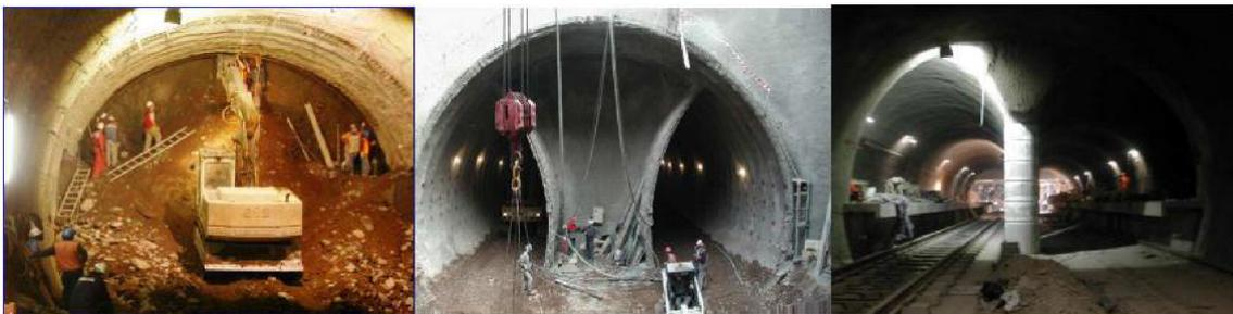
Figura 4-6-2: Estación construida mediante método NATM.
