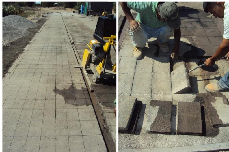
**Fotografía 16.-** Cortadora asfáltica de pavimento HMA y AE para obtener bloques de asfalto (cortes longitudinales y transversales). Obtención de los Bloques asfálticos retirando del colchón de arena.
