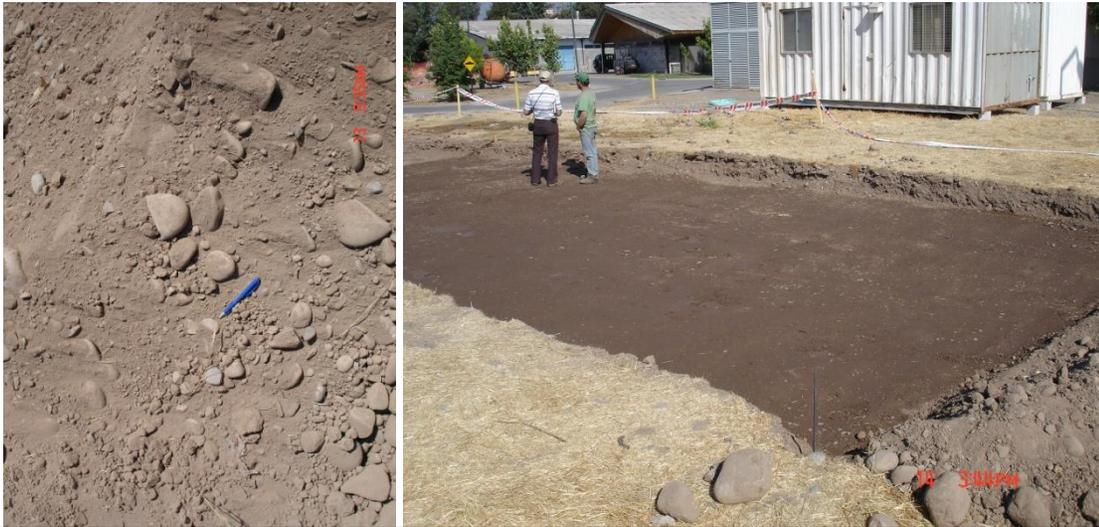
**Fotografía 3.-** Miércoles 13-01-2010. Material existente como sub-rasante en el tramo de prueba. Sector poniente. Jueves 14-01-2010. Terminado parcial a nivel de subrasante con superficie húmeda.
