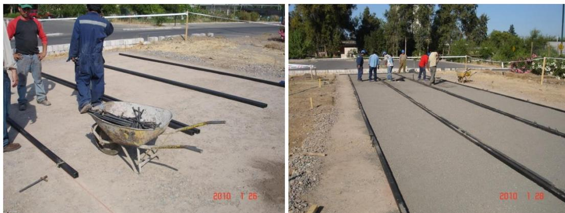
**Fotografía 6.-** Martes 26-01-2010. Colocación de perfil de acero para guías en la colocación de mezcla de Asfalto en Caliente y en Frio. Jueves 28-01-2010. Colocación de Arena Fina sobre capa de Base para evitar adherencia entre capa de carpeta asfáltica y base.
