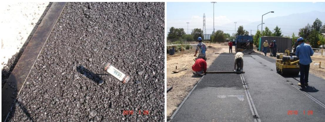
**Fotografía 8.-** Jueves 28-01-2010. Control de temperatura de la mezcla asfáltica en caliente durante su colocación y compactación sobre tramo de prueba. Enrasado y compactación de mezcla asfáltica en caliente en tramo de prueba (20 m de longitud).
