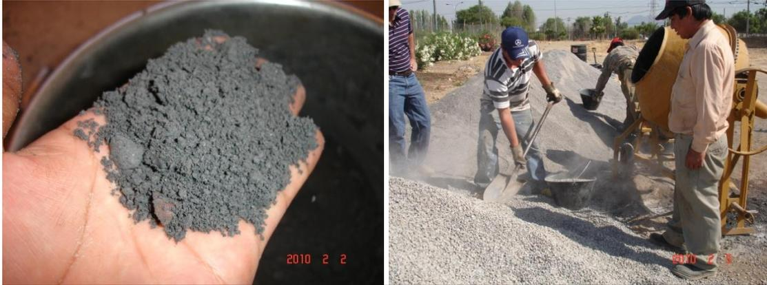
**Fotografía 9.-** Martes 02-02-2010. Diseño y Elaboración de mezcla de emulsión asfáltica en laboratorio. Viernes 05-02-2010. Elaboración de Mezcla de emulsión asfáltica en campo para la construcción de capa asfáltica desde la abscisa 0+020 - 0+040.
