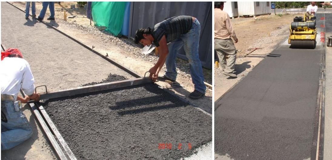
**Fotografía 10.-** Viernes 05-02-2010. Enrasado de mezcla de emulsión asfáltica en campo. Compactación de capa de emulsión asfáltica en campo desde la abscisa 0+020 lado derecho.
