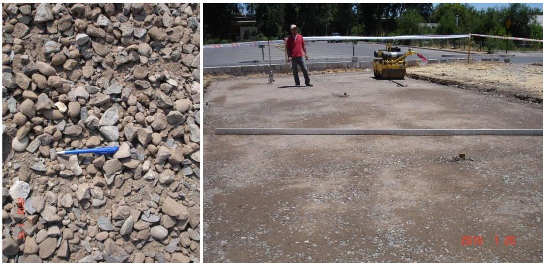
**Fotografía 5.-** Viernes 15-01-2010. Stock de material granular para construcción de capa de base en tramo de prueba. Miércoles 20-01-2010. Comprobación de irregularidad superficial a nivel de base – primera capa ( $e= 15$  cm).
