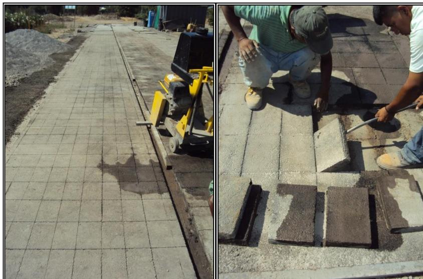
Figura 5-3: Cortado Longitudinal y Transversal sobre Carpeta Asfáltica para Obtención de Bloques de Asfalto.
