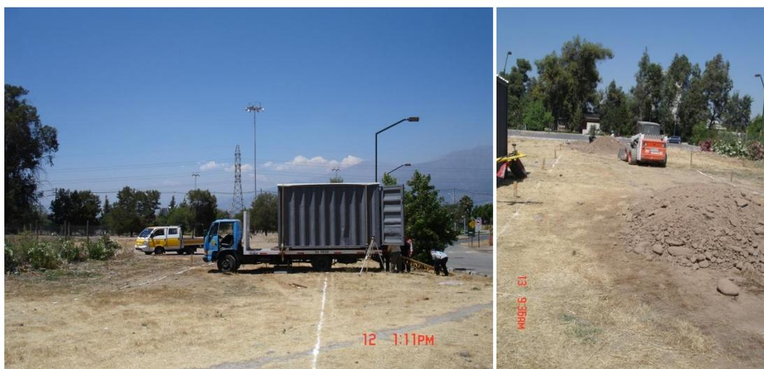
**Fotografía 2.-** Martes 12-01-2010. Instalación de equipos y materiales de la compañía constructora THX encargada de la construcción de tramo de prueba y con representante Sr. Juan Sandoval; y Miércoles 13-01-2010. Inicio de trabajo en construcción de tramo de prueba sector Poniente con equipo de Bobcat y personal humano (1 jefe de trabajo, 1 maestro y 3 peones)
