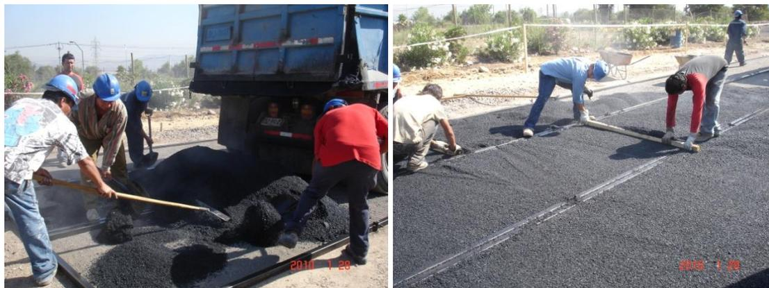
**Fotografía 7.-** Jueves 28-01-2010. Vaciado de mezcla asfáltica en caliente sobre calzada de prueba entre las abscisas 0+000 - 0+020 (ancho de 4.5 m). Enrasado de mezcla asfáltica.
