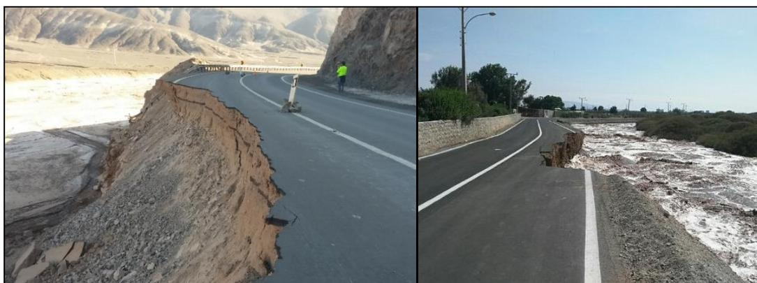
**Figura 13:** Terraplenes de caminos bidireccionales expuestos paralelamente a flujos en Chile.
