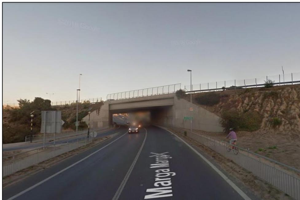
**Figura A-7. Cruce bajo nivel en intersección en trébol en autopista**
