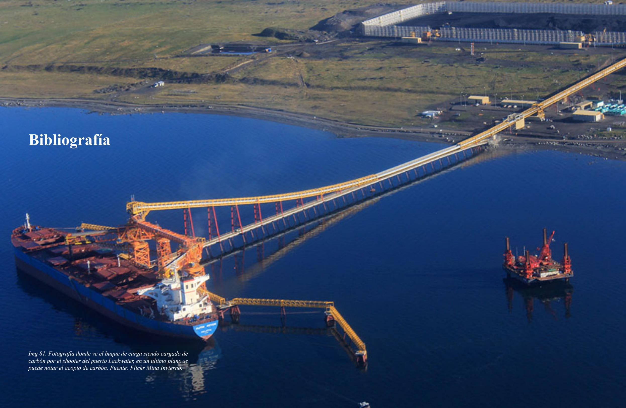
*Img 81. Fotografía donde ve el buque de carga siendo cargado de carbón por el shooter del puerto Lackwater; en un ultimo plano se puede notar el acopio de carbón. Fuente: Flickr Mina Invierno.*
