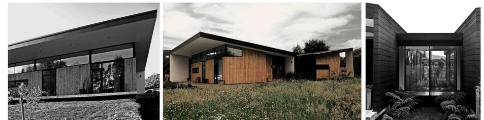
Fig 1. Vista fachada sur. Ventanas superiores para ventilación cruzada.
