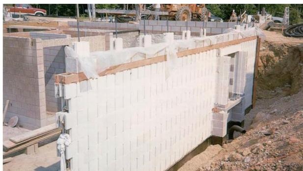
**Figura 2. 11 Casa en albañilería postensada (Crigler, 1991)**
