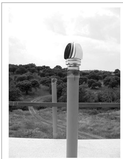
Figura 15. En esta fotografía se encuentra abierto el tiro de la arqueta situada bajo el módulo mientras que el otro tubo está sellado
