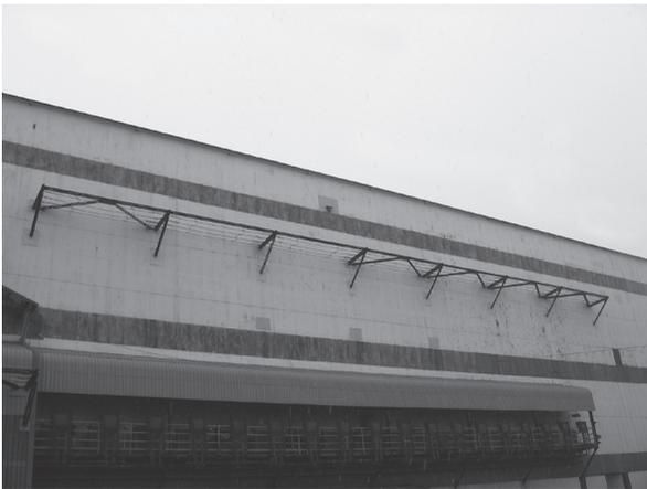
FOTO 11 *Cubierta metálica con dispositivos de seguridad para el despeje manual de nieve (J. P. Mery, marzo 2007)*
