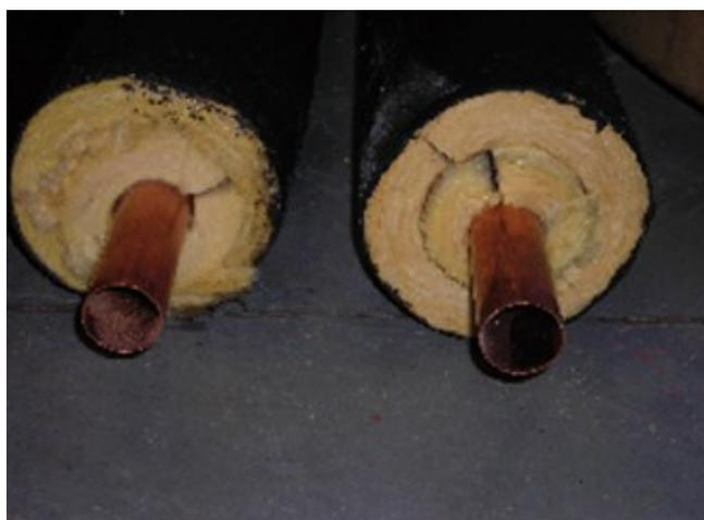
Figura 10. Aislación de las tuberías
