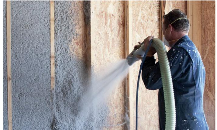
figura 68: aislante de celulosa proyectada
