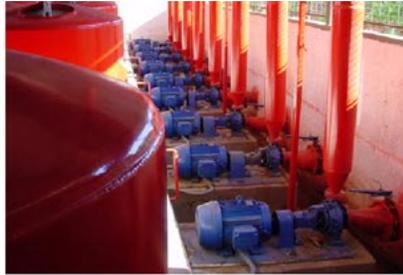
Motobomba centrífuga del cabezal de riego.
