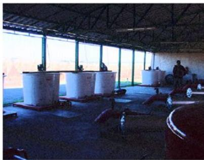
Estanque de fertilizante con bombas agitadoras
