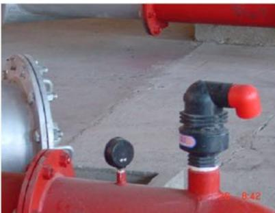
Válvula de aire en el cabezal y manómetro
