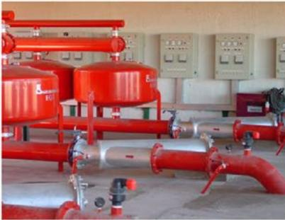
Tablero eléctrico, filtro de grava, filtro de malla y válvulas de aire
