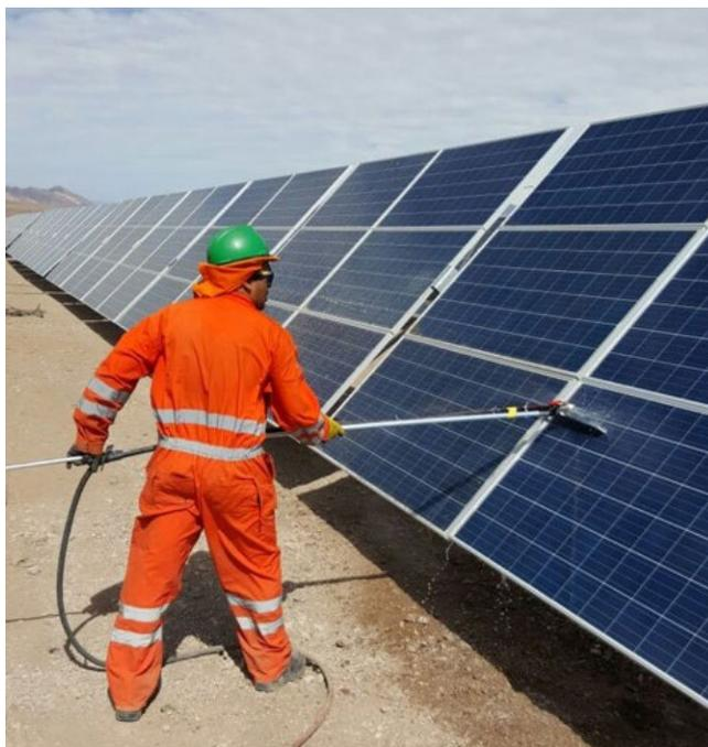
Imagen 14. Limpieza de paneles solares
