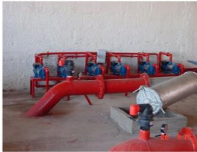
Bomba inyectora de fertilizante
