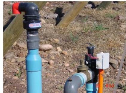
Válvula de aire y válvula de solenoide
