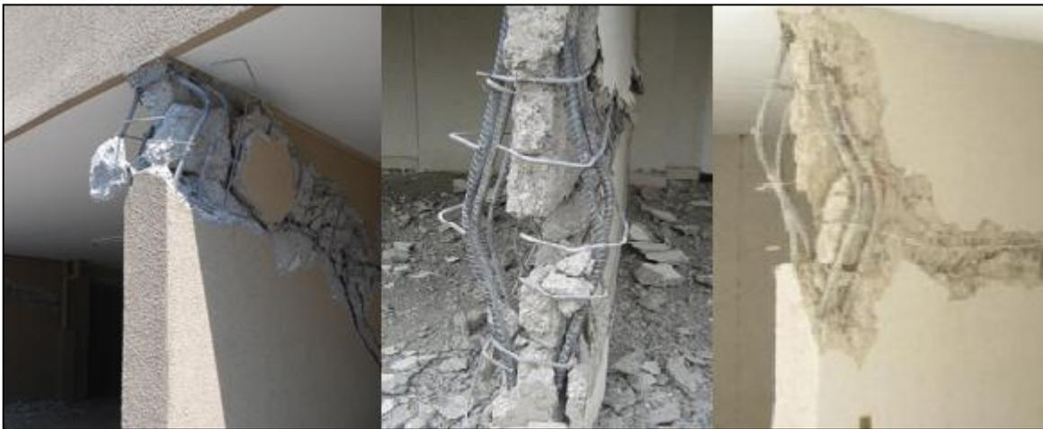
Figura 1: Daño en flexo-compresión observado en muros durante el terremoto de febrero 27, 2010.
