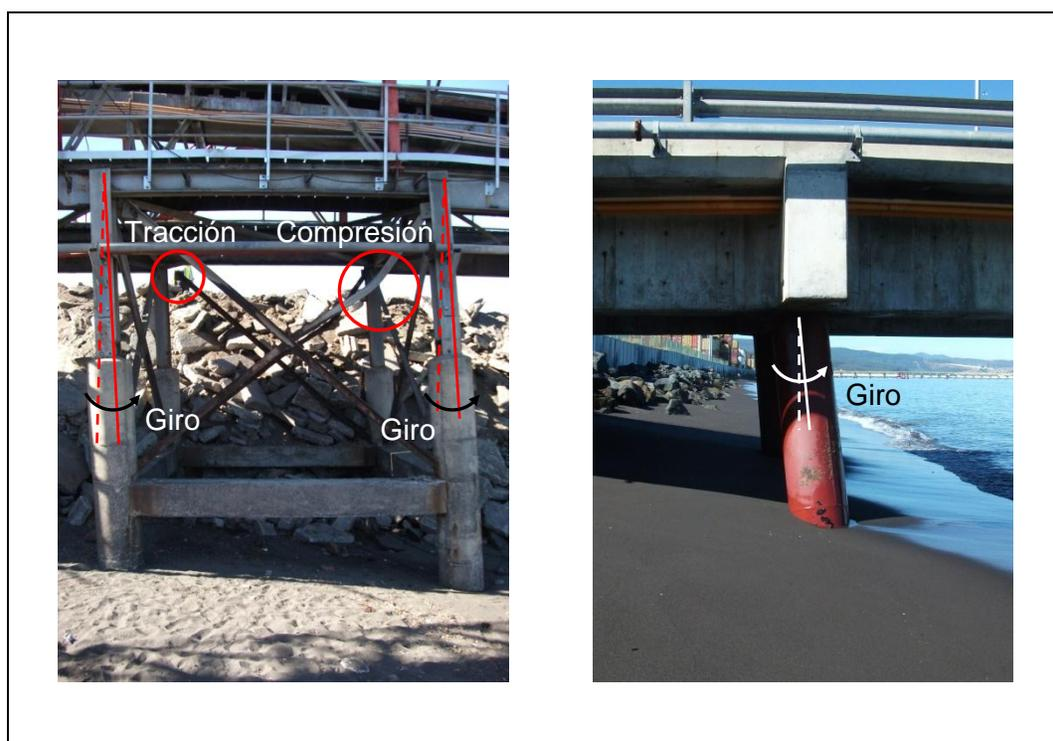
Figura 2-10: Inclínación del sistema de fundación debido a Lateral Spreading. (a)
