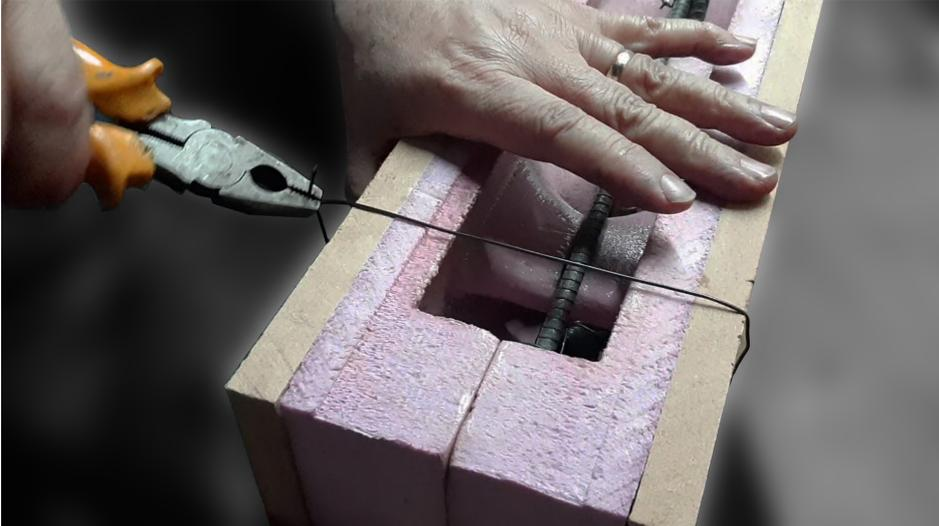
Otros alambres que permiten controlar la parte superior de la enfierradura mientras el hormigón H40 se vierte a la mezcla permiten mantenerla recta dentro del molde, La mezcla se depositaba primeramente en las trabéculas que comunicaban la parte superior con la interior de la viga.
