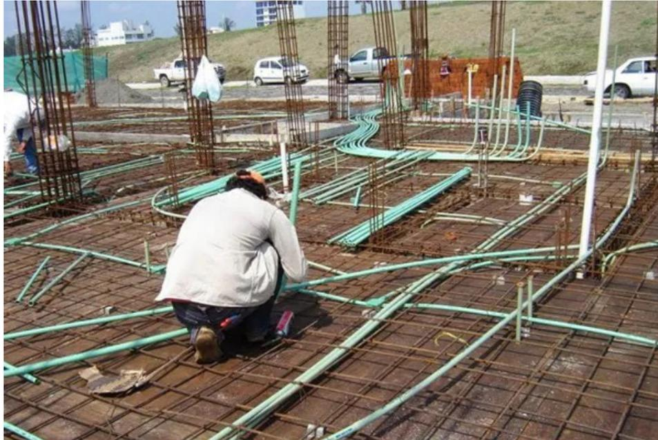
*Figura 39. Fotografía de proceso constructivo de instalaciones.
