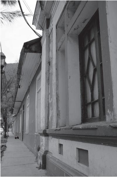
IMG\_18: Detalle ventana con marco de madera y muros de ladrillo y cal, utilizados en las fachadas del Hotel Francia.
