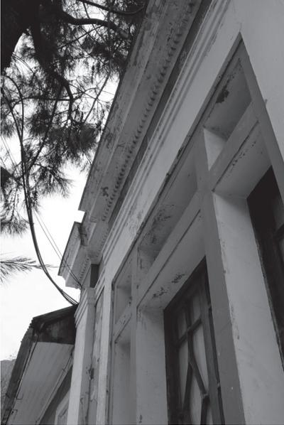
IMG\_19: Detalle ventana con marco de madera y muros de ladrillo y cal, utilizados en las fachadas del Hotel Francia.
