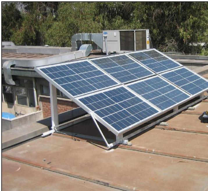
**Figura 3.1** Arreglo de Paneles Solares instalado en techo de Edificio DIE-PUC
