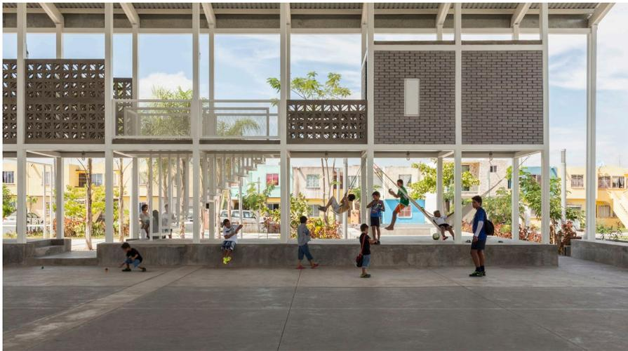
Fig. 50. Interior de la cancha techada, puede observarse cómo la estructura de la cubierta alberga el programa.
