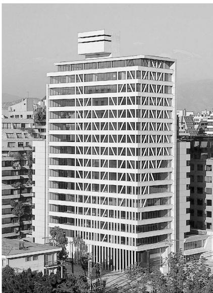
**Fig. 18** Esquema de arriostramiento diagonal en fachadas de edificio Manantiales.
