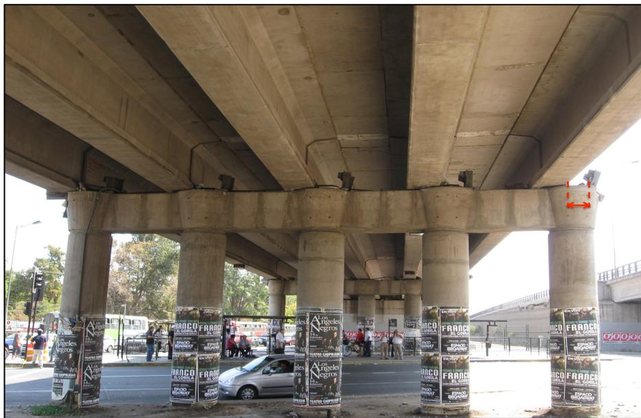
Figura 5-5: Desplazamiento remanente del PS Independencia luego del terremoto del Maule del 2010
