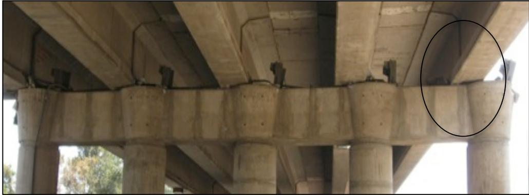
Figura 4-10: Disposición de apoyo elastomérico en paso superior Independencia
