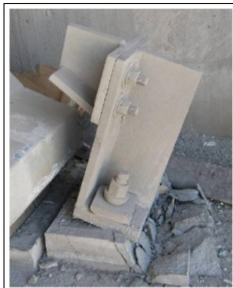
Figura 3-2: Tope lateral de acero del PS Américo Vesputio dañado durante el Terremoto del Maule 2010
