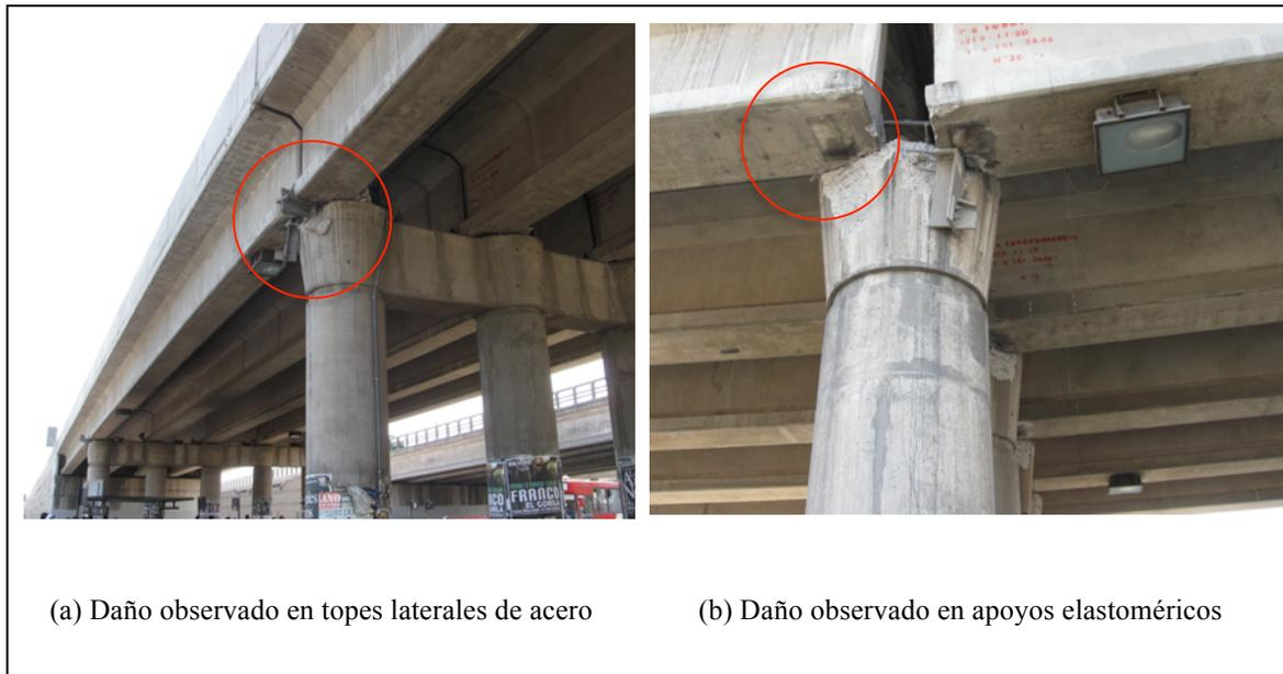
Figura 5-4: Daño observado en el PS Independencia luego del terremoto del Maule del 2010
