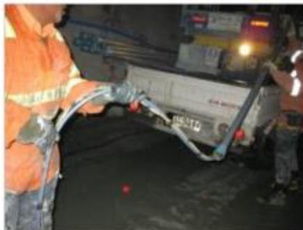
Figura 199: Introducción de piola y guirnalda a tubo de PVC
