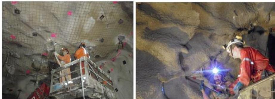
Figura 202: Inyección de lechada en taco
