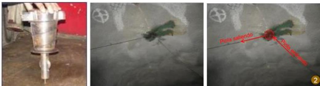
Figura 196: Instalación de anclaje y piola de acero
