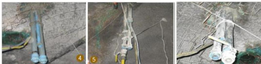
Figura 201: Inyección de resina en Taco
