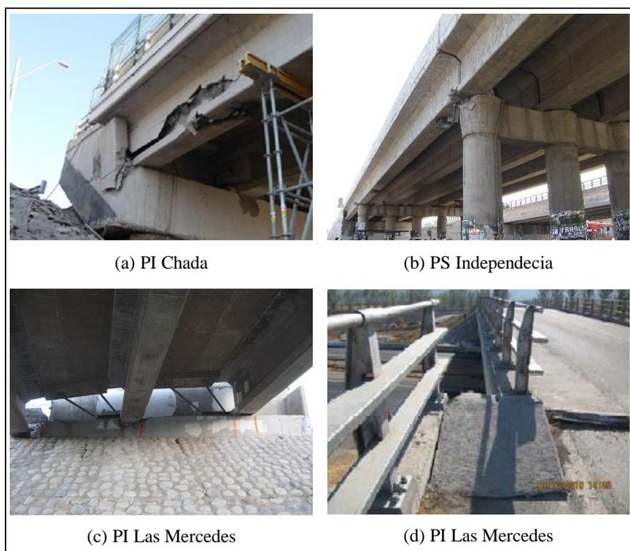
Figura 1.1: Daño observado en pasos inferiores (PI) y superiores (PS) debido al terremoto del Maule 2010
