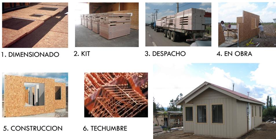
**Ilustración 13. Etapas de ejecución modelo SIP de TECNOPANEL.**
