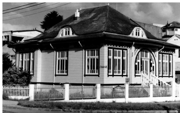
Figura 6. Ejemplo de las galerías presentes en las tipologías alemanas construidas en el sur de Chile. Fuente: La escuela de carpinteros alemanes de Puerto Montt, su formación e influencia más allá de las fronteras Cheribinni (2016)
