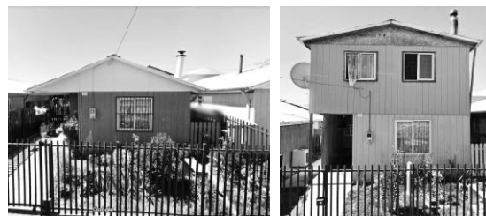
Figura 4. Ejemplo de ampliación de vivienda en Valdivia. A la izquierda el modelo inicial y a su derecha la ampliación. Fuente: Google StreetView
