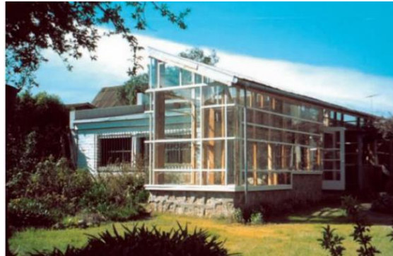
Figura 12. Vista suroeste de Galería solar casa Kapstein. Fuente: Revista AoA N°9, 2008.
