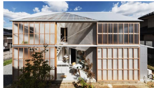
Figura 16. Casa en Sonobe, fachada sur. Fuente: Tato Architects.
